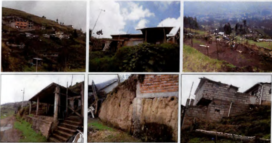
8.1.3 Servicios básicos en el sector existentes
