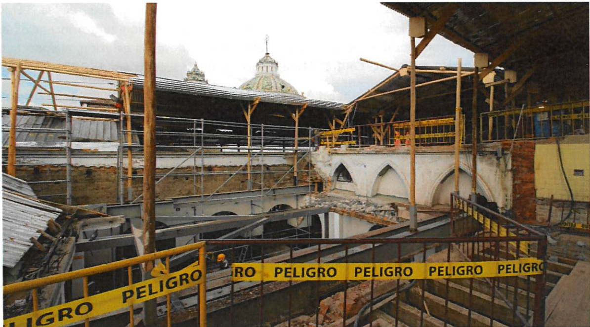
Vaciado del interior, con estructura metálica de apeo
