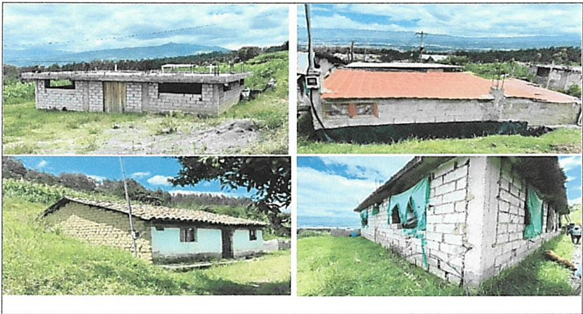
Gráfico 3. Vivienda con calidad estructural reducida del AHHyC “Miranda Grande las Praderas”.
