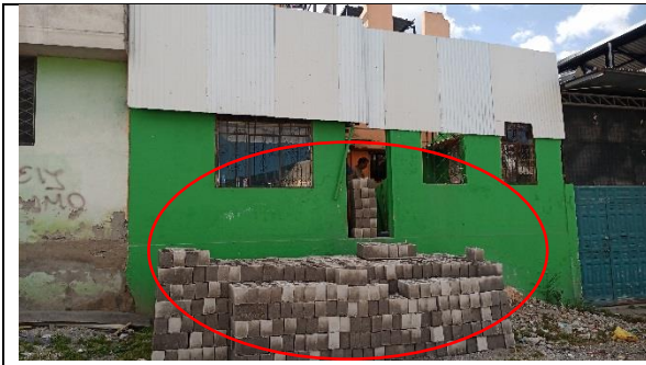
Foto 7.1.5. Predio 318510 con un aparentemente proceso constructivo.
