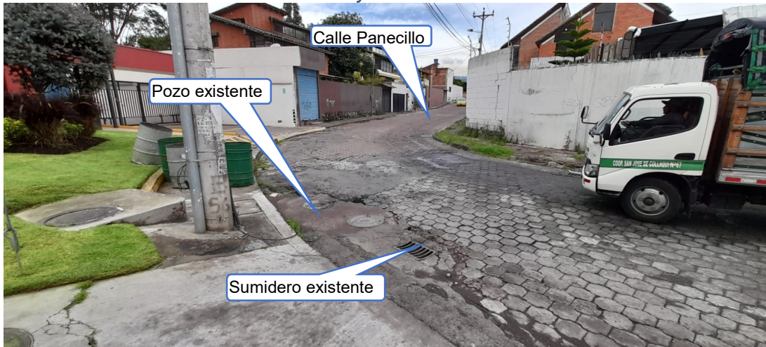
FOTO 3: “Pozos y sumideros existentes”
