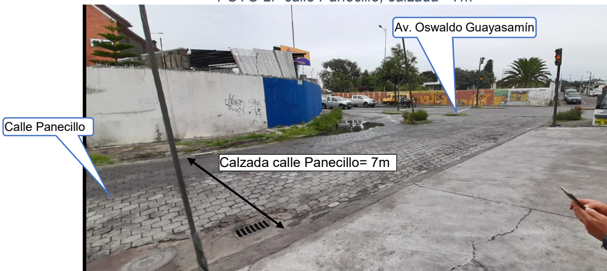
FOTO 2: “calle Panecillo, calzada= 7m”
