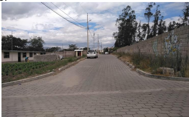
Ilustración 8.- CALLE S/N (E31)
