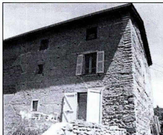
Ilustración 12 Imagen referencial de una edificación con estructura de tapial Fuente: https://tierrah.wordpress.com/author/julierabaud/
