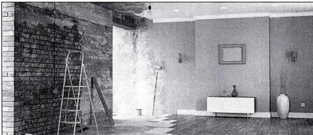
Ilustración 18 Ejemplo de una construcción " en acabados"
