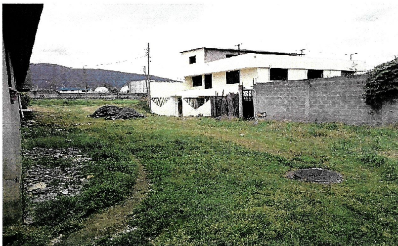
Imagen 4. Calle S49C – Estado actual en tierra.
