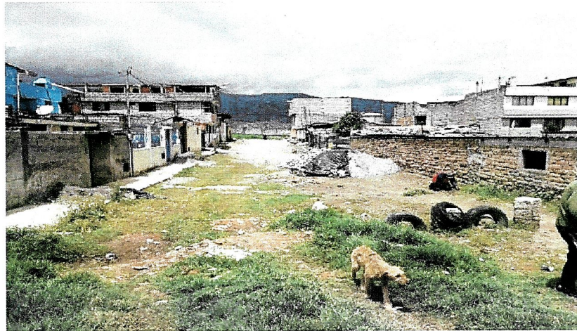
Imagen 5. Calle S50A – Estado actual en tierra.
