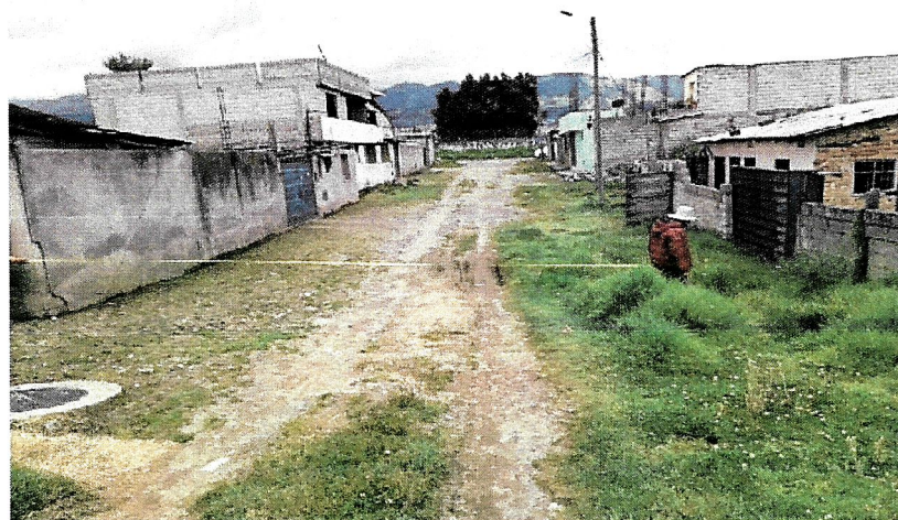
Imagen 7. Calle S50C– Estado actual en tierra
