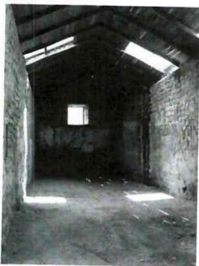
Descripción: Vista del interior de la Casa de Hacienda Rumicucho
