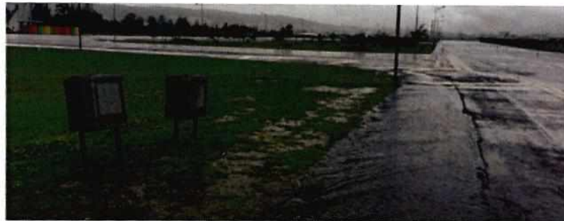
Imagen 19: Sector de parque con lluvia (área de pista, estancamiento, canalización)
