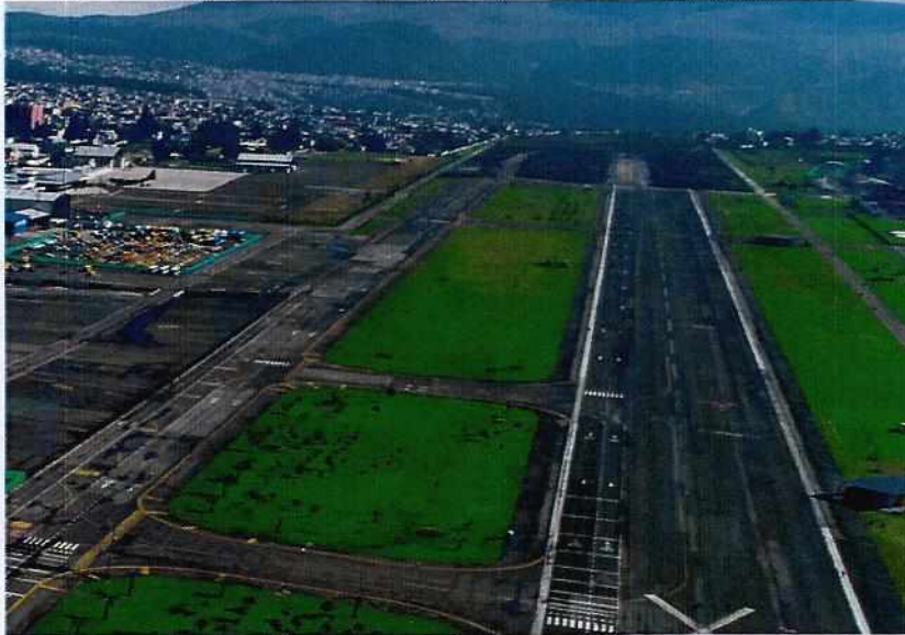
Imagen 12. Límite de intervención zona norte del p. Bicentenario
