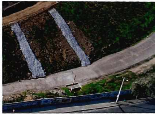
Imagen 6: Canalización calle Tufiño
