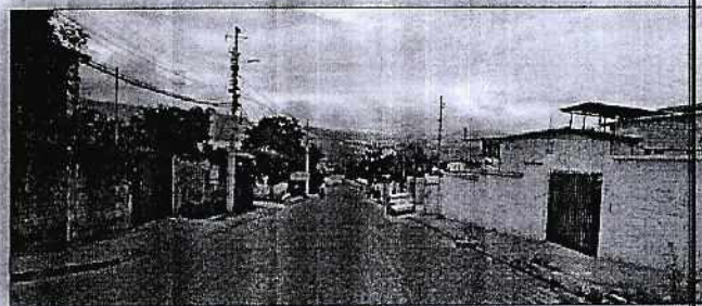
FIGURA No. 3 Ascenso por la calle Carchi hacia la Ruta Viva.
