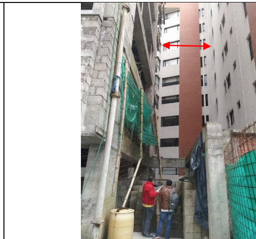
Imagen N°6: Vista de distancia entre bloques del lado norte.
