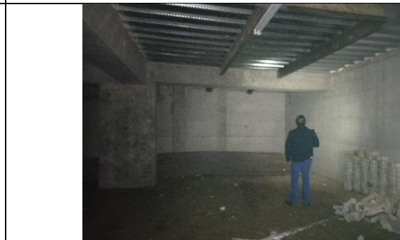
Imagen N°10: Vista de subsuelo en estado de obra gris.
