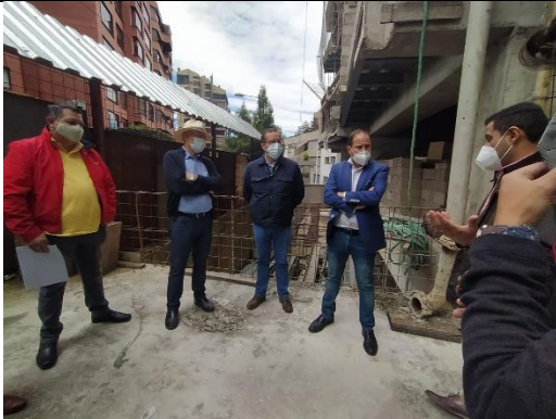
Imagen N°3: Vista de la inspección conjunta.
