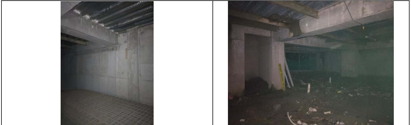
Imagen N°11: Vista de subsuelo 5
