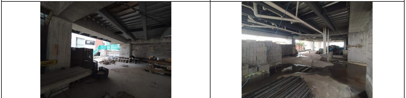
Imagen N°15: Vista al interior de la obra en estado de obra gris.
