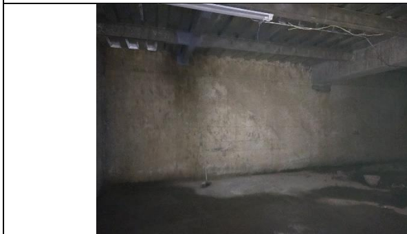
Imagen N°9: Vista muros perimetrales en el subsuelo 3.
