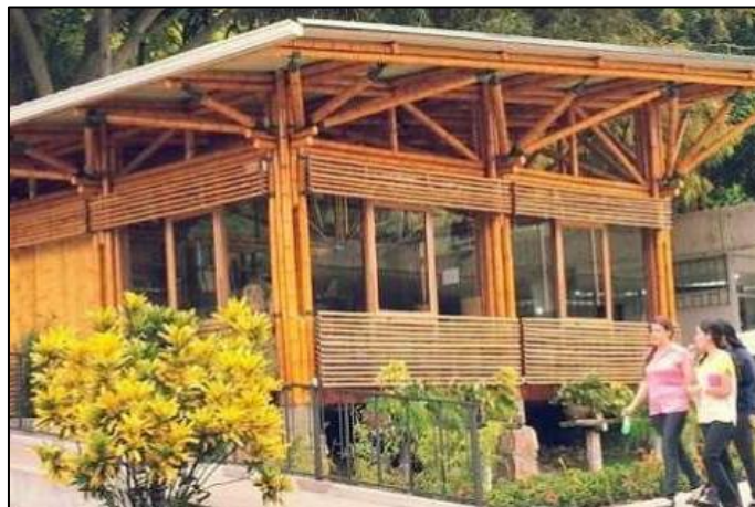
Imagen referencial de una edificación con estructura de caña guadua
