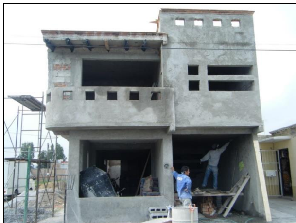
Ilustración 17 Ejemplo de una construcción " en obra gris"
