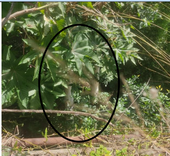
Imagen N° 1: Vista de la tubería hacia la quebrada.
