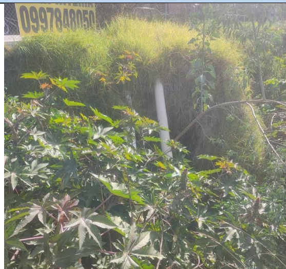
Imagen N° 2: Vista de la tubería hacia la quebrada
