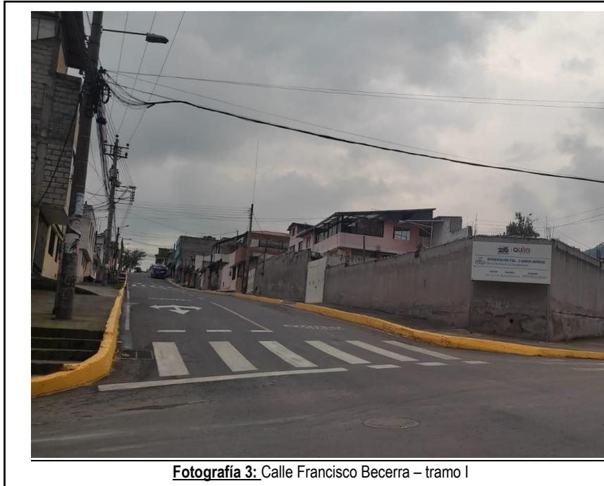
Realizada las mediciones en sitio existe un ancho de vía consolidada de 12.50 metros, con bordillos y aceras consolidadas de 3.00 metros (lado este de la vía) y 1.50 metros (lado oeste de la vía) y una calzada de 8.00 metros; razón por la cual se considera en la presente propuesta de trazado vial mantener la sección transversal de 12.50 metros según lo consolidado en sitio.
