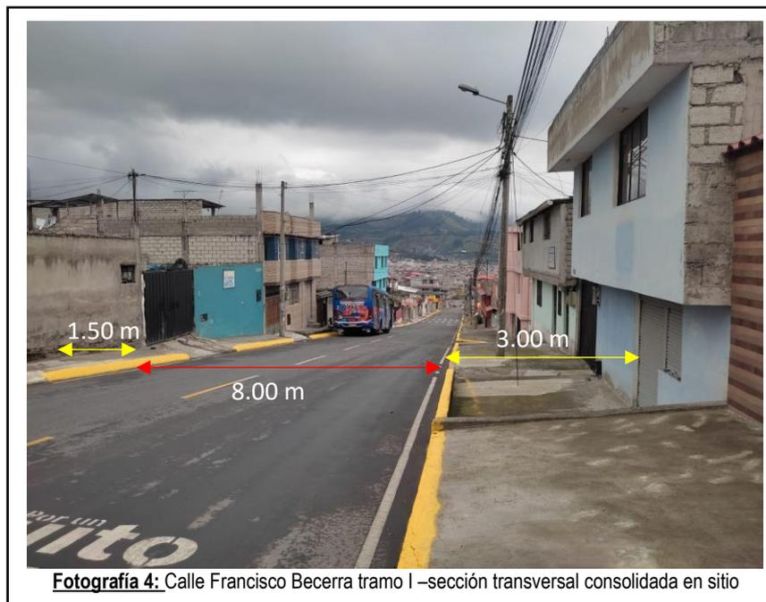
En sitio se encuentra consolidada con una capa asfáltica; cuenta con servicios básicos como agua potable y energía eléctrica con postes de hormigón, con una consolidación de viviendas con sus cerramientos de un 100%.
