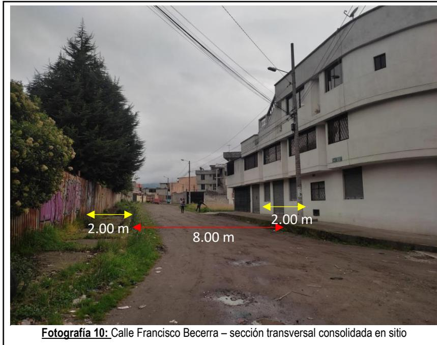
La Calle Francisco Becerra (Oe9C) TRAMO II en sitio se encuentra aperturada en tierra; cuenta con servicios básicos como agua potable y energía eléctrica con postes de hormigón, con una consolidación de viviendas con sus cerramientos de un 80%.
