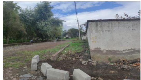
Fotografía 18 Calle B y C, aceras encespadas
