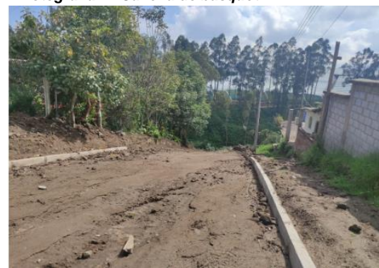
Fotografía 16 Calle C, sin intervención curva de retorno
