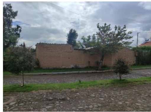
Fotografía 10 Calle A, frente del lote 5554283
