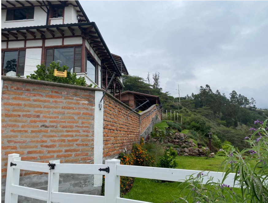
Ilustración 5. Vista 2 referente a implantación – Área verde, propiedad municipal. Fuente: Dirección Metropolitana de Gestión de Bienes Inmuebles
