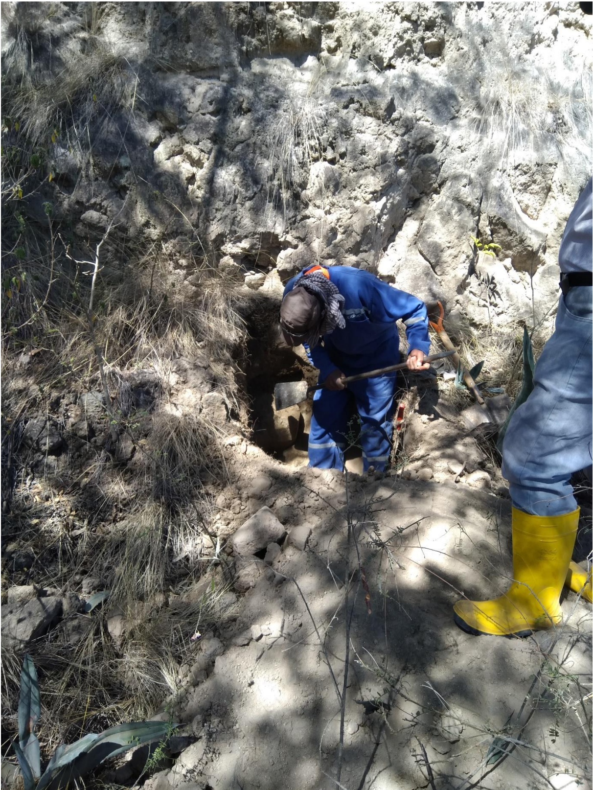
Obtención de la muestra por medio de excavación de calicata.
