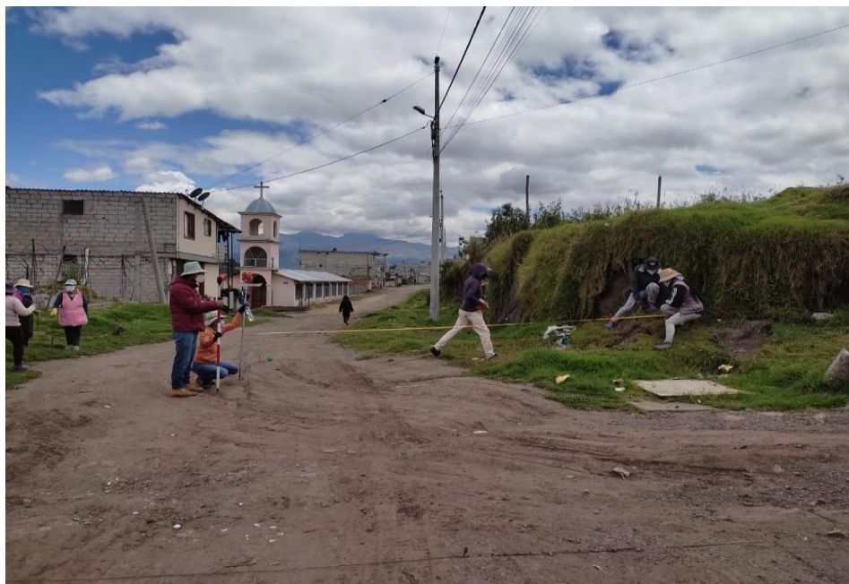
Fotografía 2. Socialización técnica- verificación de laterales de la vía
