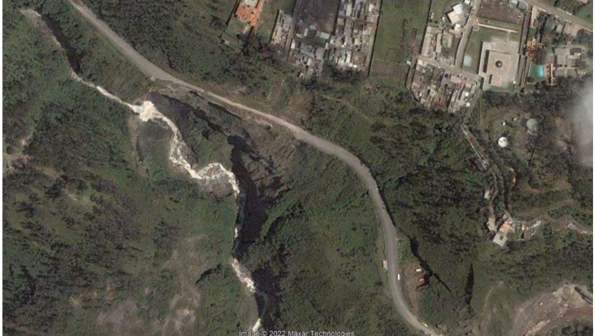
Figura 1. Deslizamiento en la antigua vía a Tumbaco, año 2003 (Fuente: Google Earth).
