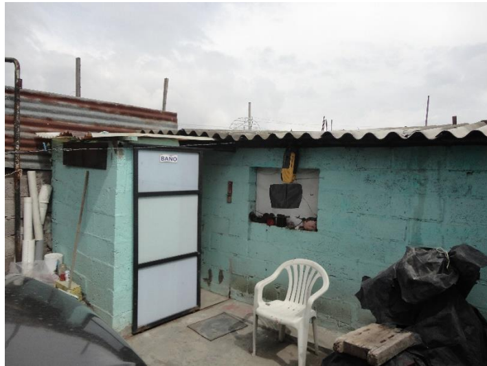
FACHADA BAÑO Y CONSTRUCCIÓN 2
