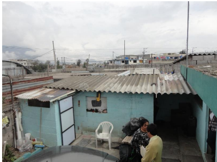
CONSTRUCCIÓN 2, BAÑO, AL FONDO LINDERO OESTE
