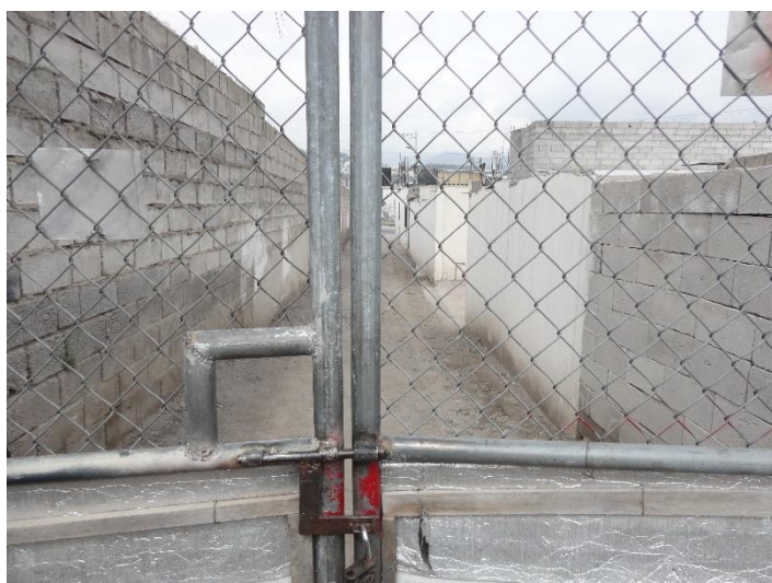
INGRESO PASAJE COMÚN
