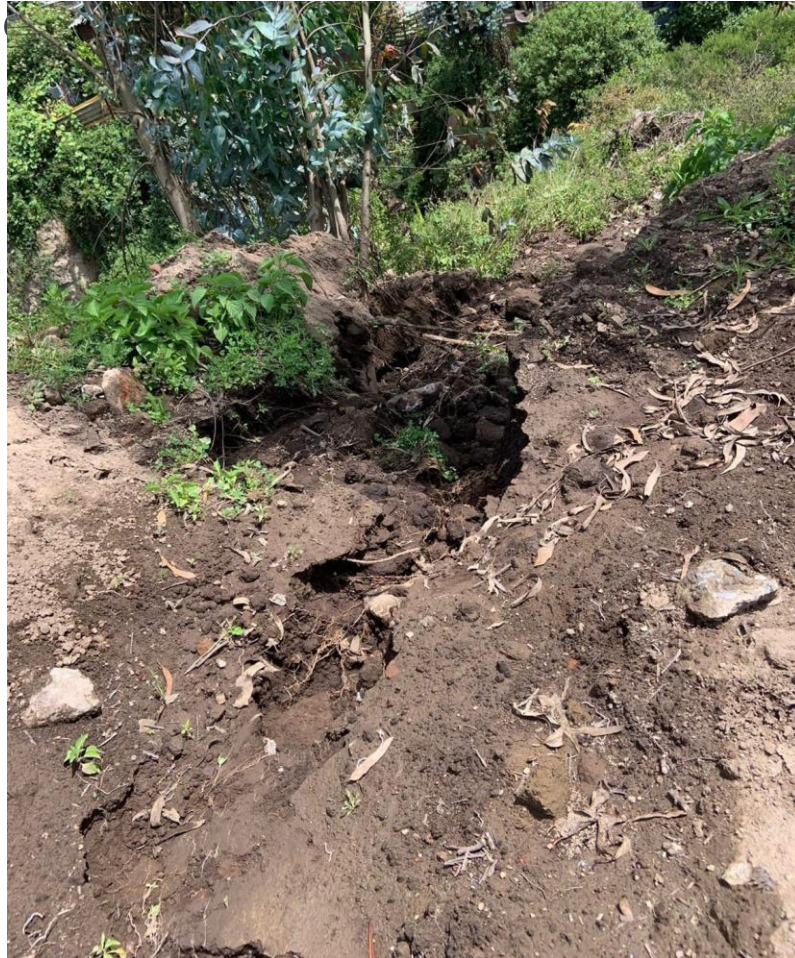
Imagen N°1: colapso de pozo de recepción de aguas lluvias
