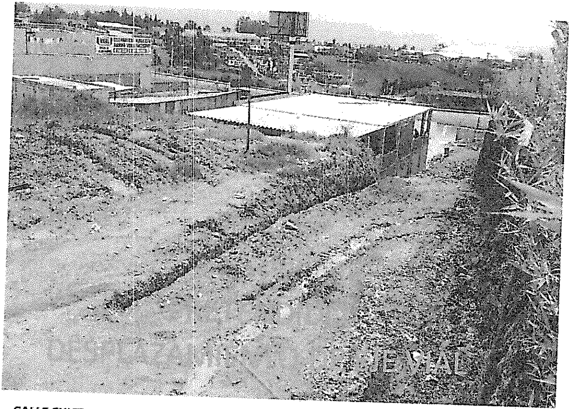
CALLE EXISTENTE ARBITRARIAMENTE PRETENDIDA DESPLAZAR POR RAMIRO GUALOTO Y DONNY ALDEÁN DE LA ADMINISTRACIÓN ZONA TUMBACO SIN CONOCIMIENTO Y AUTORIZACIÓN DE LA SECRETARÍA DE TERRITORIO, HÁBITAT Y VIVIENDA Y EL CONCEJO.
