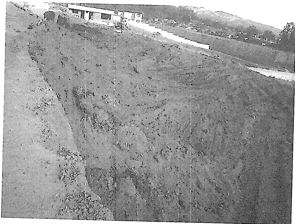
FOTO 21. RELLENO DE LA CALLE SUR REALIZADO POR FAMILIA RÍOS
