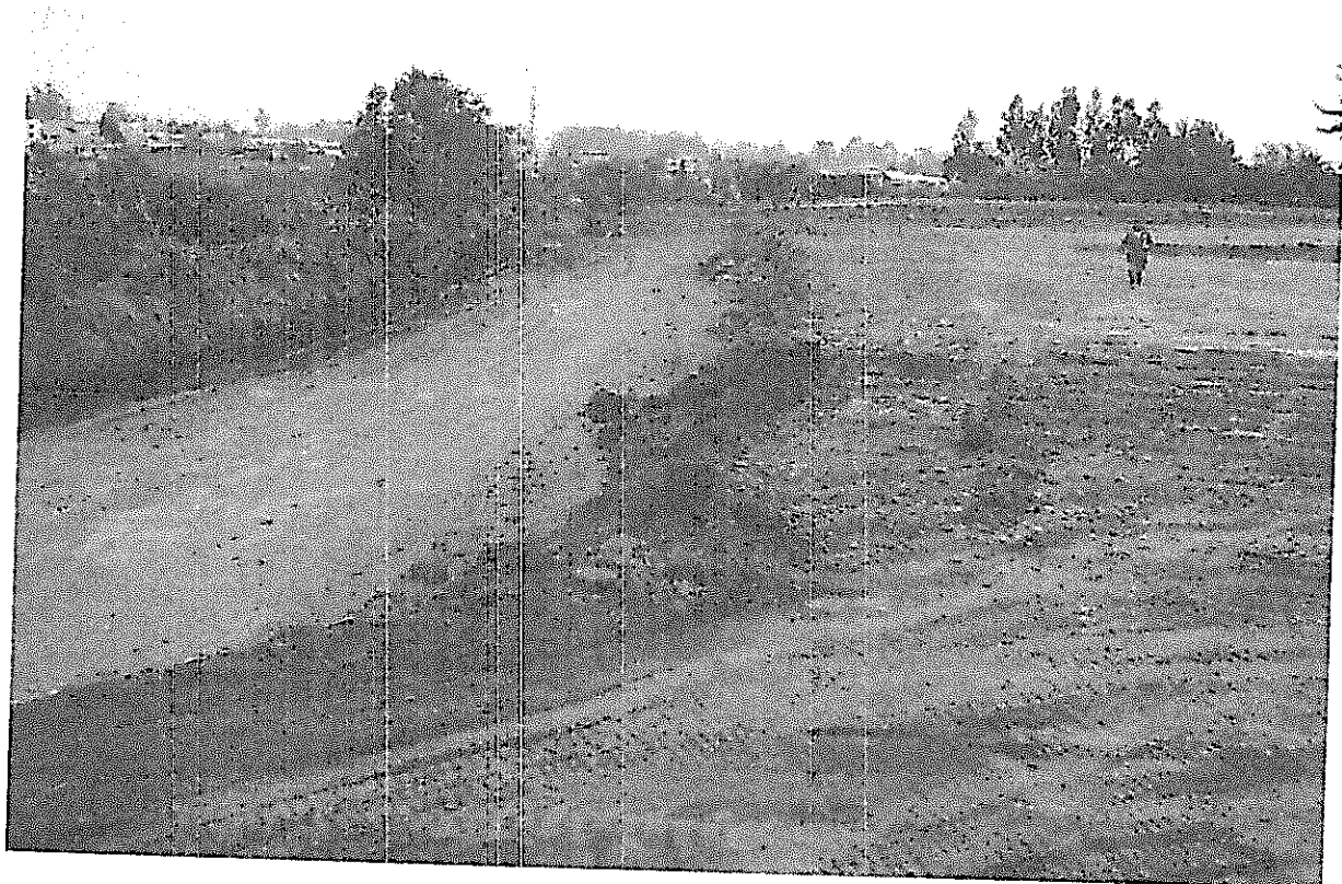
FOTO 6. MOVIMIENTO DE TIERRA CON RESPETO DEL LINDERO ORIGINAL CON LA CALLE
