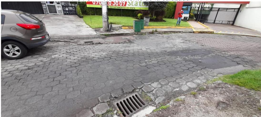
FOTO 5: “Fisura transversal del pavimento”
