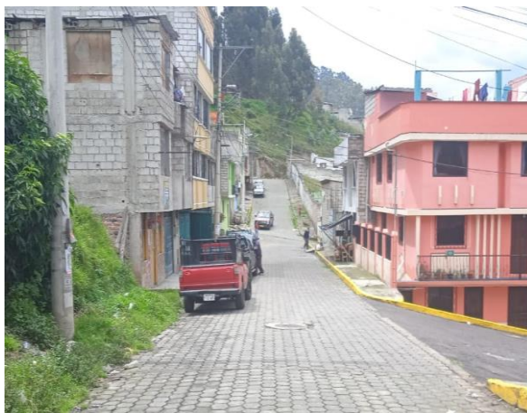
Fotografía 2: Calle E (Oe14) tramo desde S32L hasta S33
