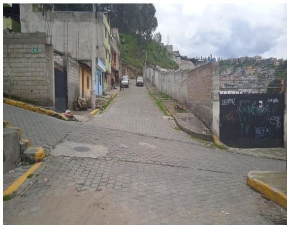
Fotografía 2: Calle E (Oe14) tramo desde S32J hasta S32L
