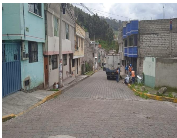
Fotografía 2: Calle E (Oe14) tramo desde S32L hasta S33A
