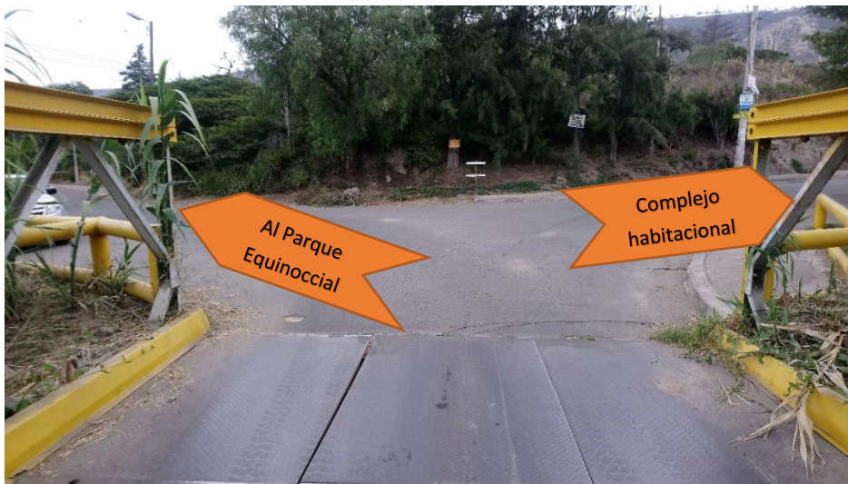
FOTO 5: Puente metálico calle Juan Bautista.
