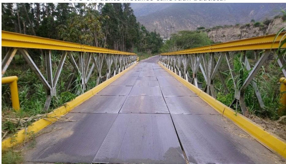
FOTO 6: Puente metálico calle Juan Bautista.
