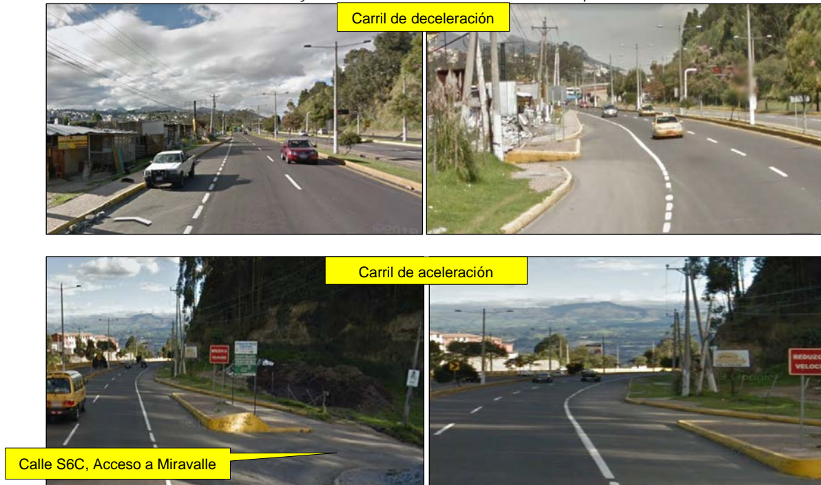
Figura No 3. Carriles de aceleración y deceleración intersección calle S6C con Autopista General Rumiñahui.
