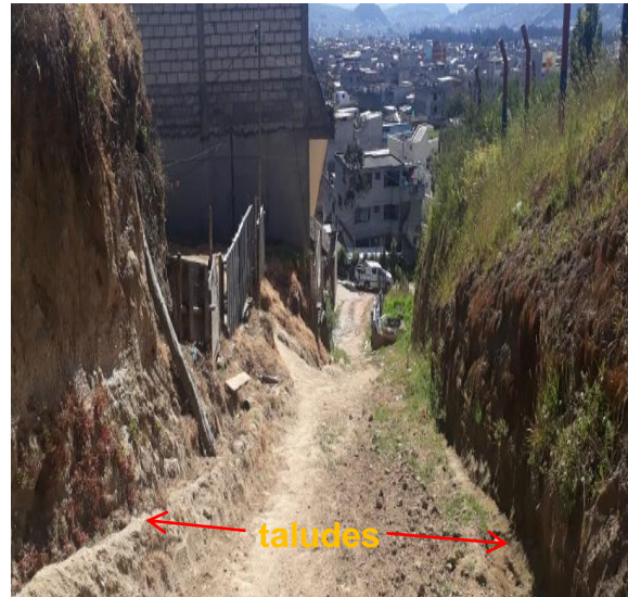
Fotografía 2: Pasaje 2, Taludes a cada lado de la vía
