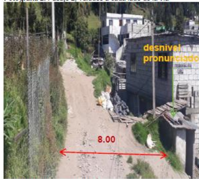
Fotografía 4: Callejón B, desnivel pronunciado
