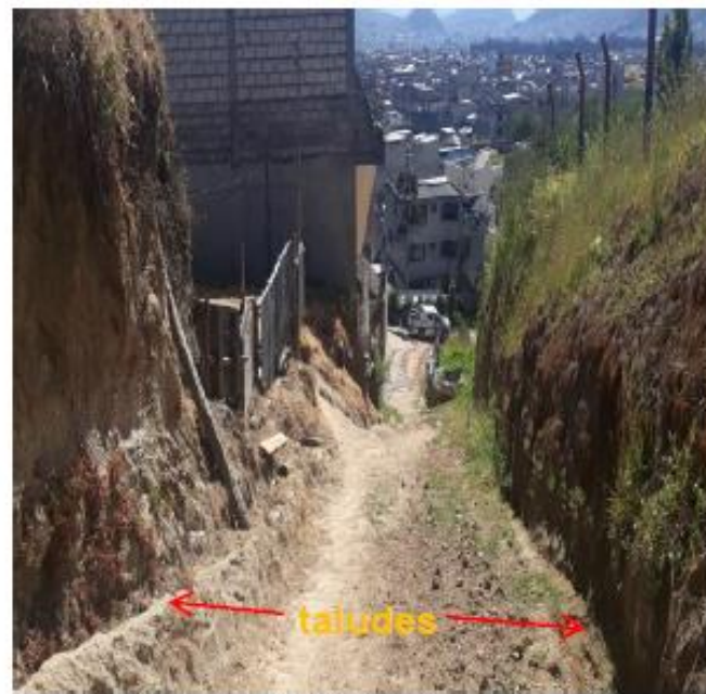
Fotografía 2: Pasaje 2, Taludes a cada lado de la vía
