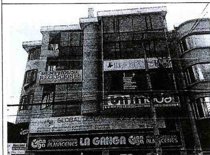
FOTO 1: Vista del establecimiento exterior.
