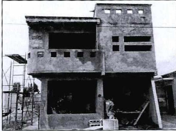
**Ilustración 17** Ejemplo de una construcción " en obra gris"
