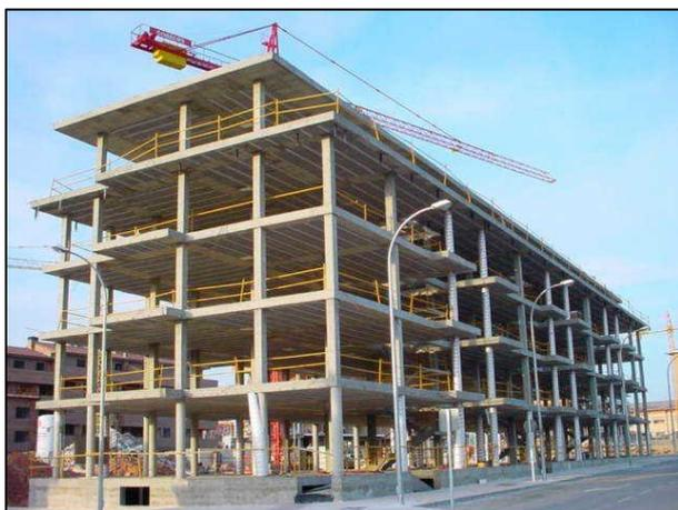
*Imagen referencial de una edificación con estructura de hormigón armado*
