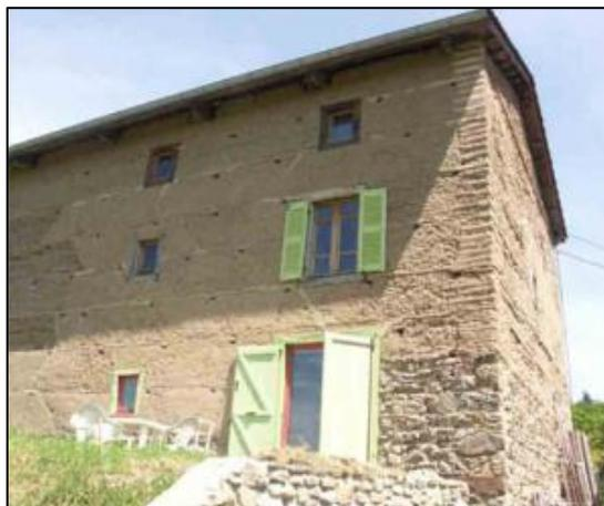
**Ilustración 12** Imagen referencial de una edificación con estructura de tapial
