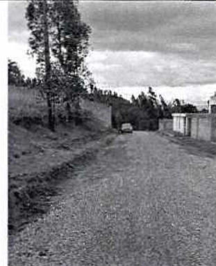
Imagen N°8: Vista de vías internas y edificaciones construidas
