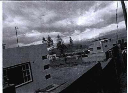
Imagen N°2: Vista de edificaciones existentes
