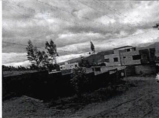
Imagen N°5: Vista de las viviendas construidas
