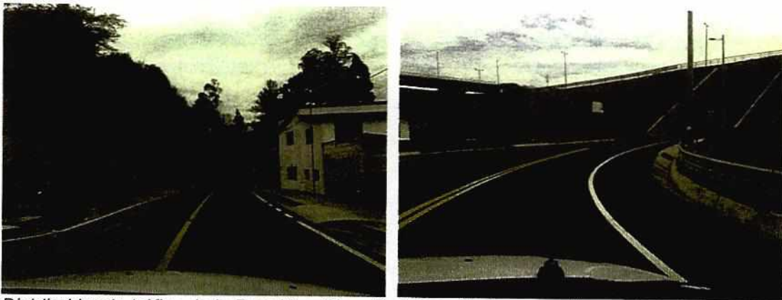
Distribuidor de tráfico de la Ruta Viva (Escalón Intervalles) y conexión con la 9na. Transversal.
