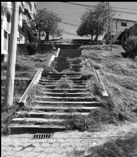
ASPECTO ACTUAL GRADAS CALLE MADRID
