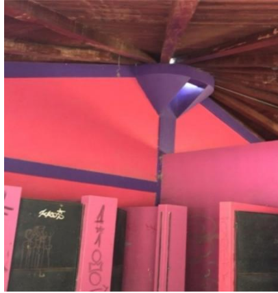
Foto 1: Techos a ser mejorados
