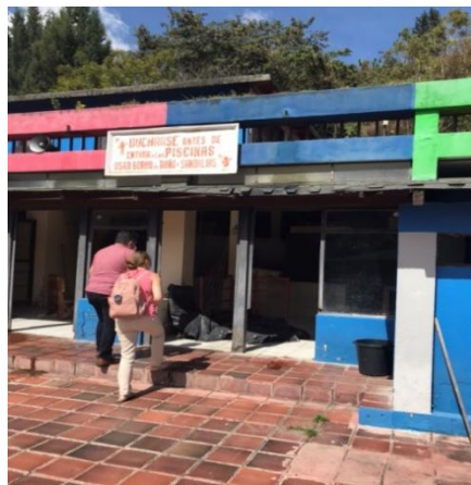
Foto 3: Instalaciones de vestidores
