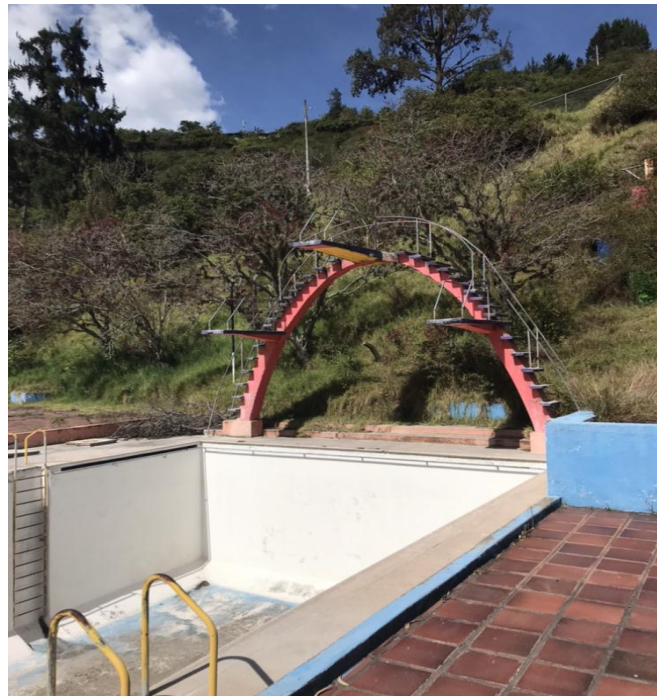
Foto 2: Instalaciones piscina olímpica
