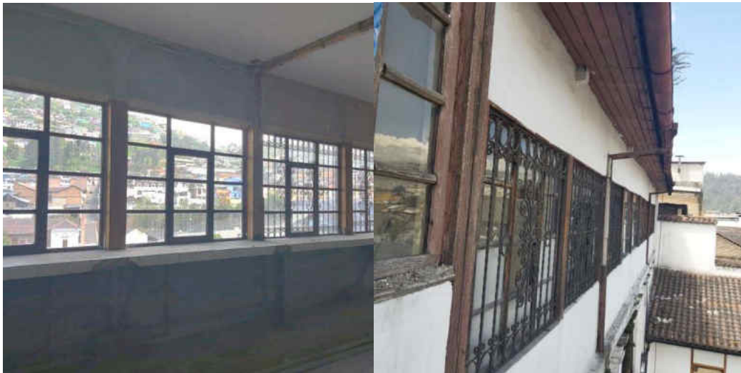
Fachada de segundo piso conformada con tabiquería de estructura de madera con malla enlucida
