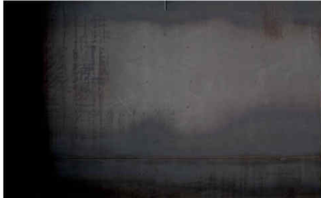
Imagen de la textura del tol de acero negro oxidado
