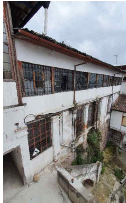
Fotografía de la fachada sobre imprenta
