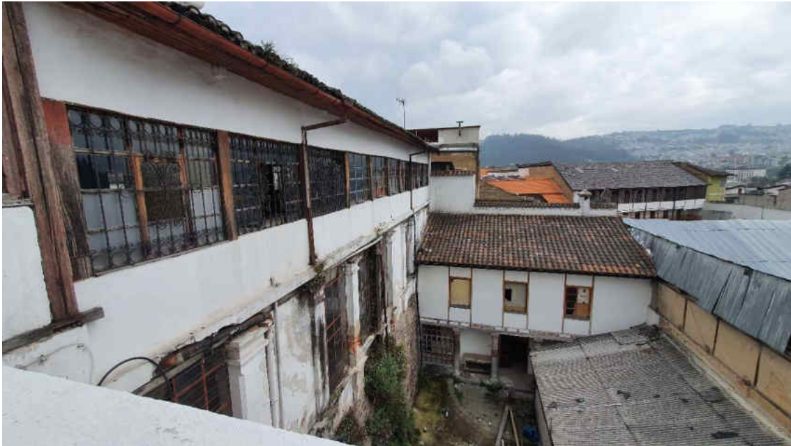
Balcón 2 con intervención, en planta alta
