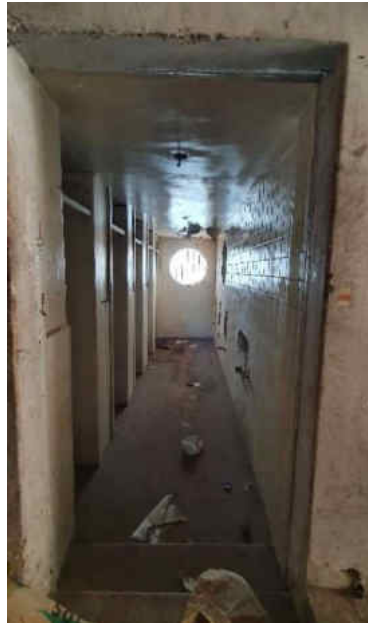
Fotografías de baterías sanitarias existentes
