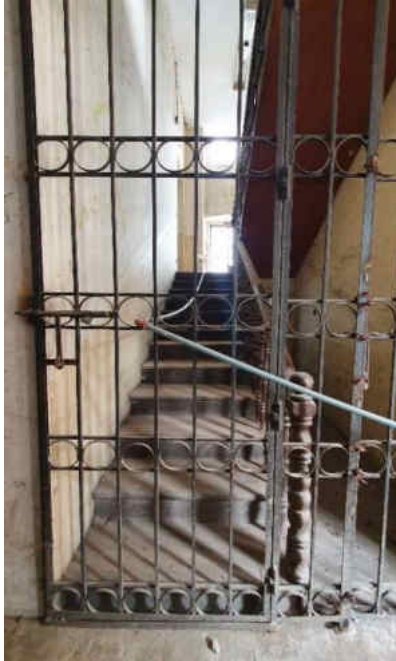
Fotografía de la circulación vertical existente
