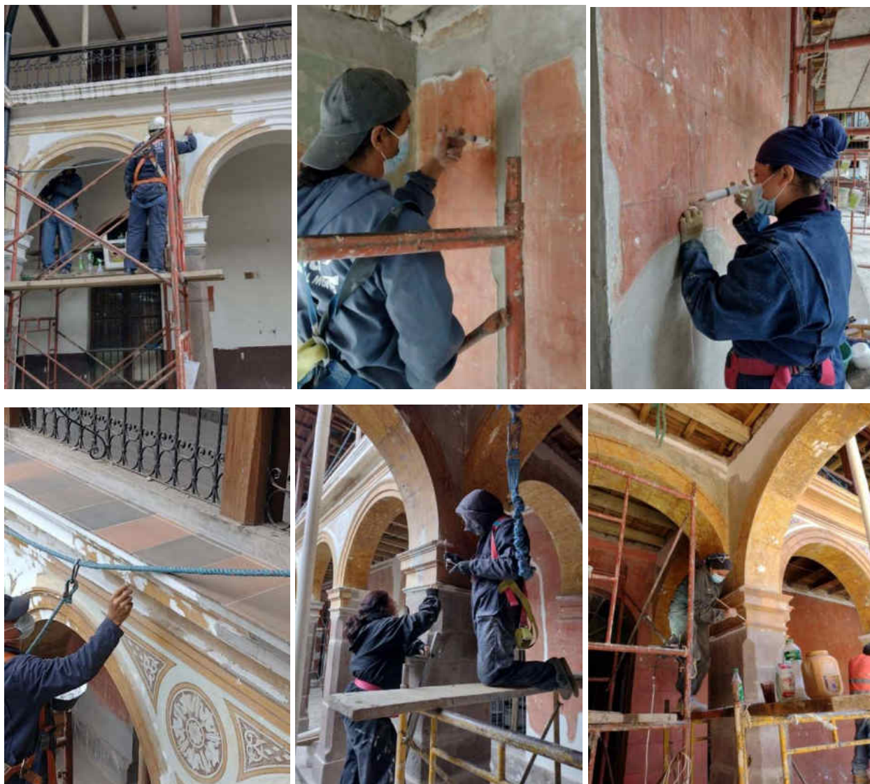
Restauración de pintura mural
