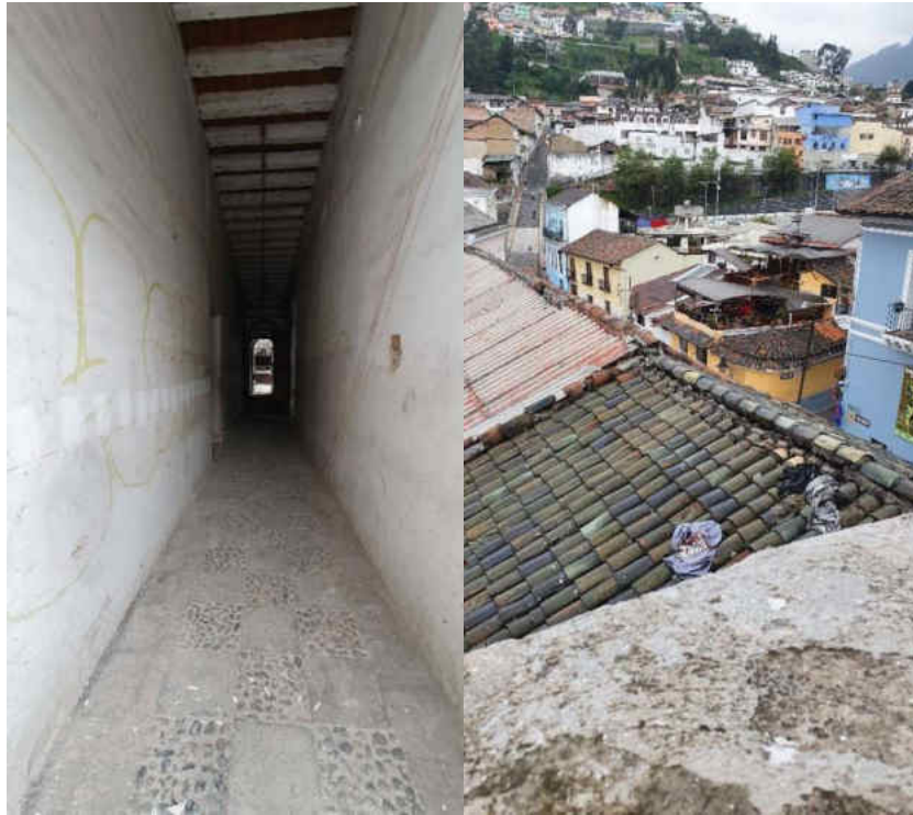
Izq: corredor de ingreso desde balcón pb; Der: Cubierta bodega lado sur
