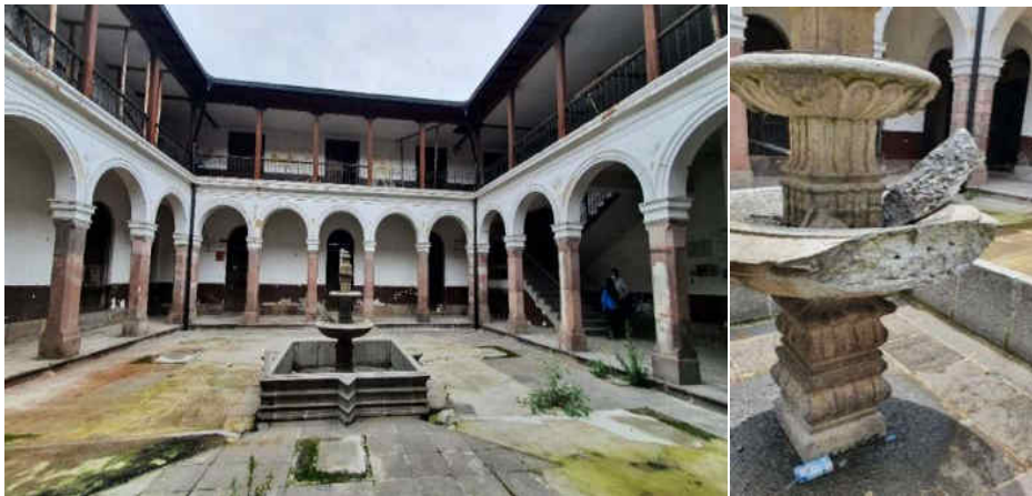
Fotografía de ubicación de la pileta en el patio central y pileta de hormigón
