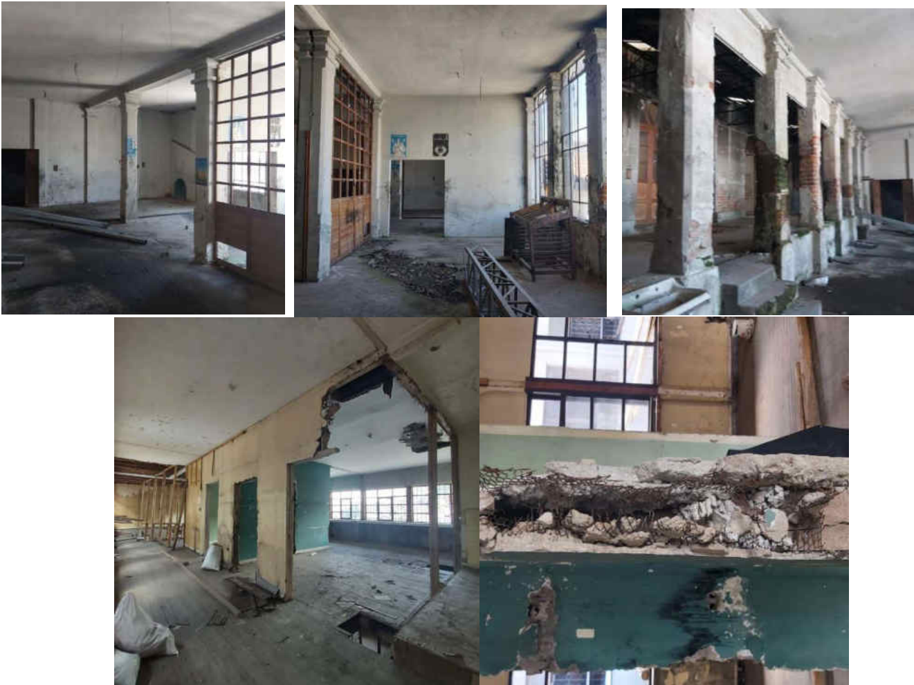
Tabiquería de estructura de madera con malla enlucida
