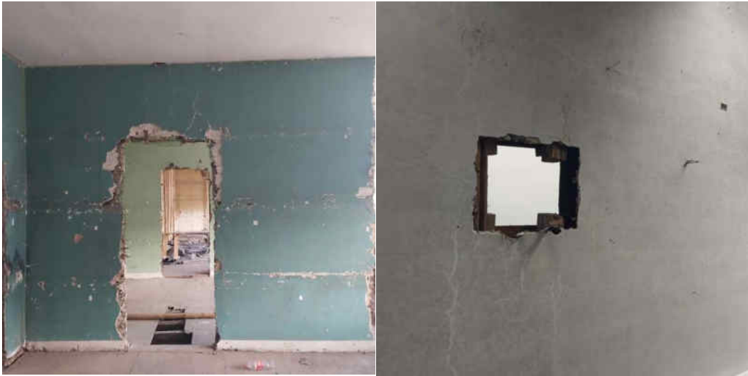
Divisiones y cielo raso de estructura de madera con malla enlucida
