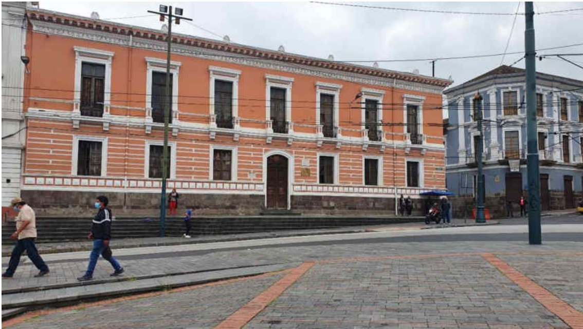
Fachada calle Vicente Rocafuerte
