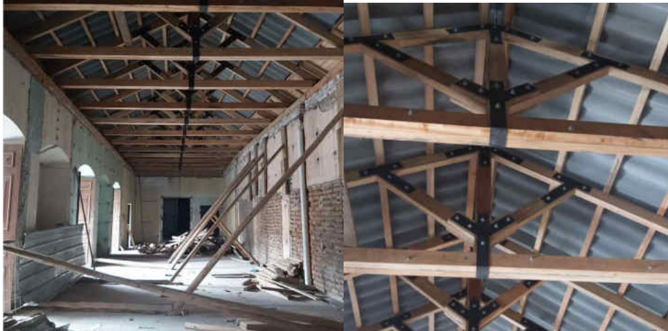
Cubierta intervenida por el IMP
