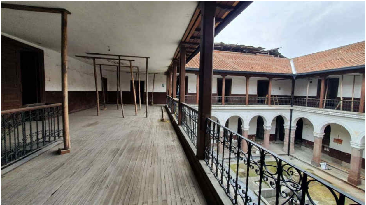
Corredor de llegada desde planta baja
