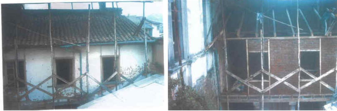
Ejecución de obra año 2005- Fuente: Archivo institucional IMP
