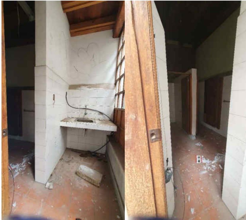
Izq: ingreso baños casa conserje; Der: baños conserje subsuelo
