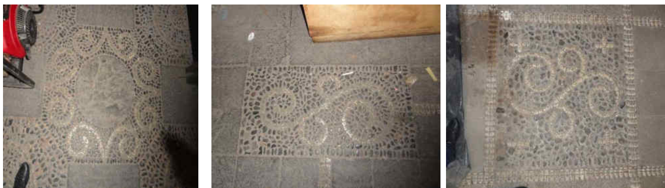
Acabados de pisos en galerías de planta baja.
