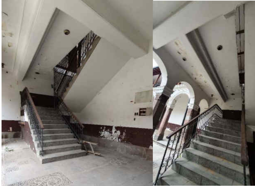
Fotografía de la circulación vertical existente
