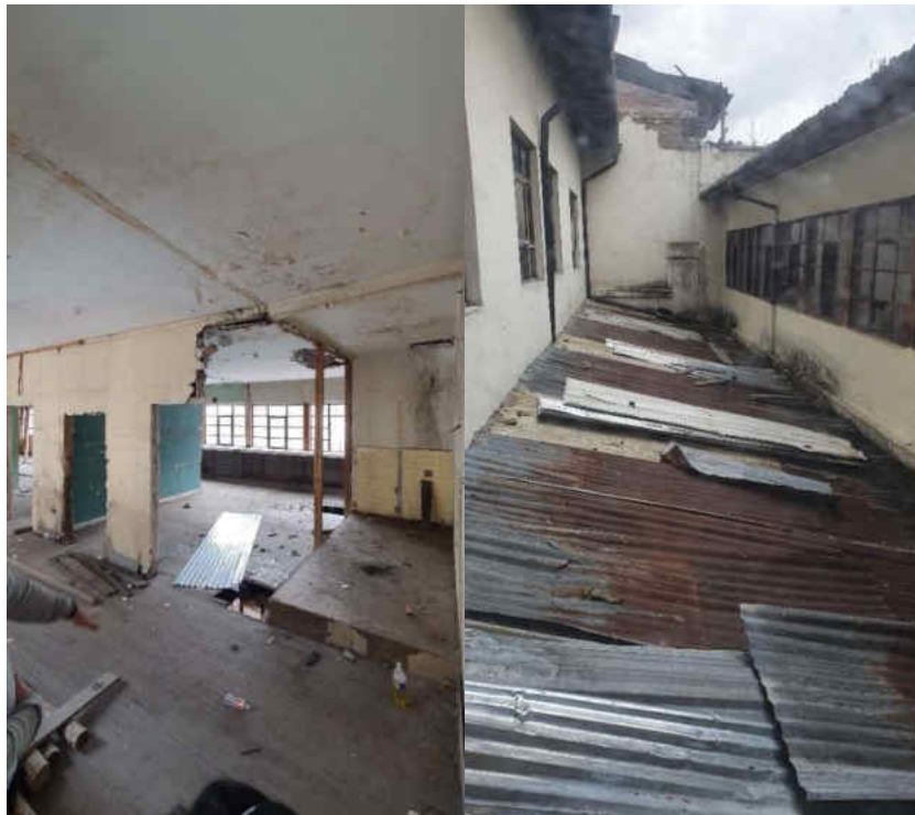
Izq: entpiso sobre imprenta; Der: cubierta sobre conector de imprenta
