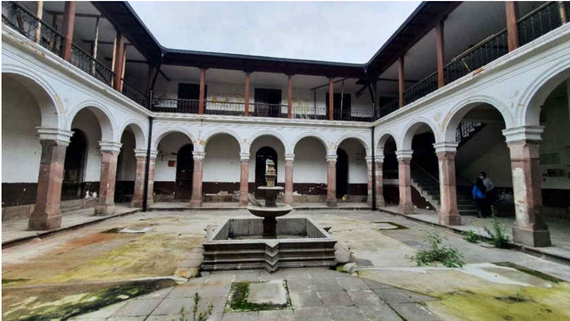
Patio central sin intervención, en planta baja
