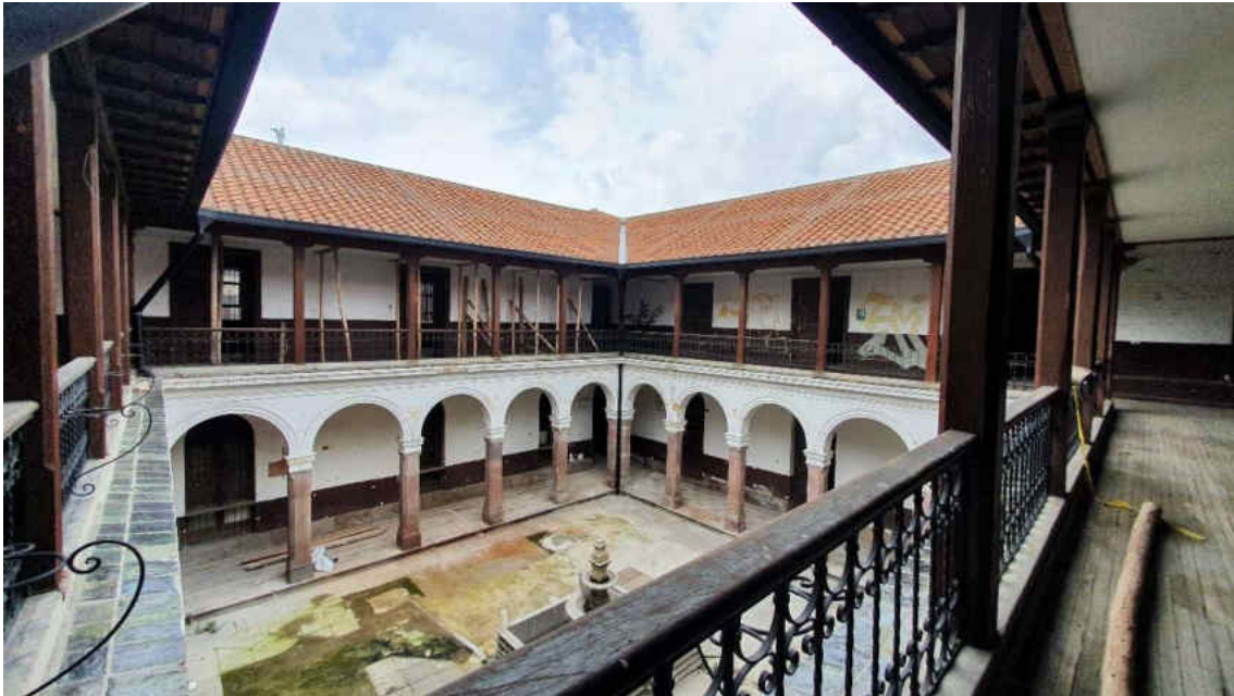
Vista al patio central sin intervención, en planta alta
