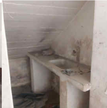
Parte posterior de escalera
