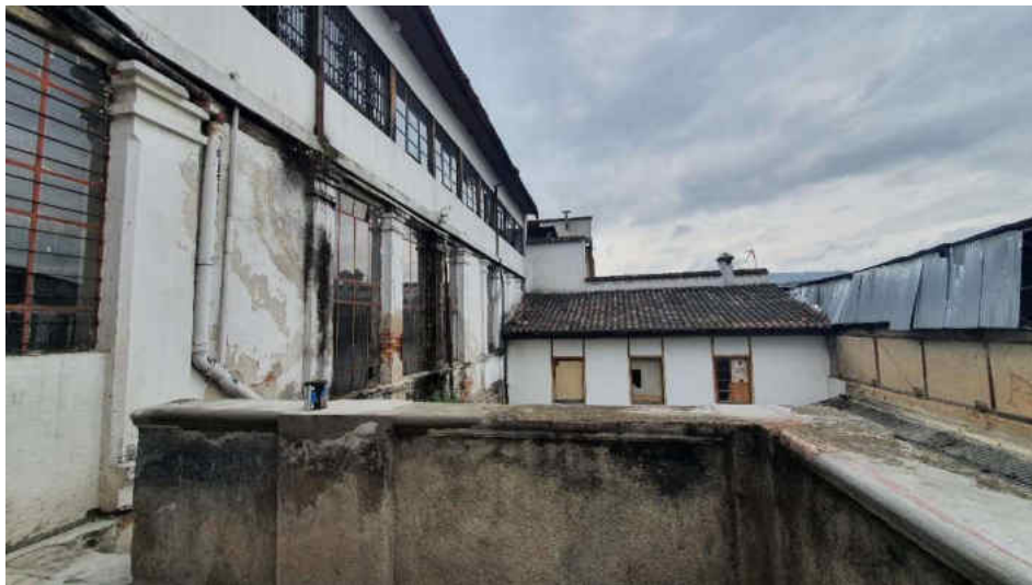
Fotografía de la fachada entrepiso sobre imprenta
