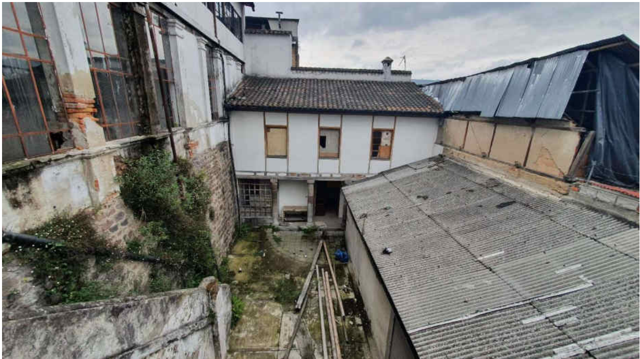
Vista del subsuelo desde el balcón de planta baja
