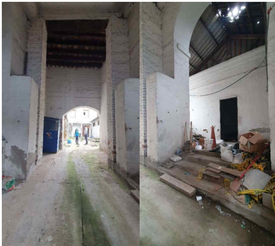
Izq: hall de ingreso calle Guayaquil; Der: ingreso cuarto lado sur
