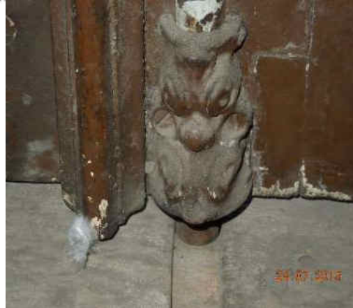
Presencia de repintes en elementos de madera y metal.
