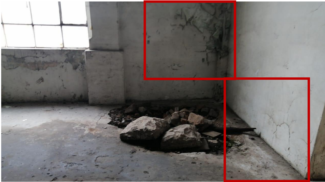
Figura 13. Fisuras superficiales
