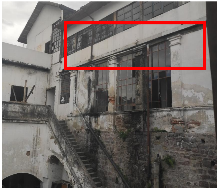
Figura 16. Viga de Solera.
