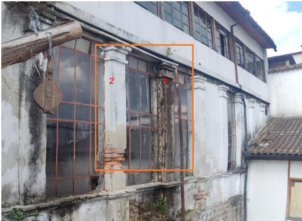
Figura 2. Columnas a reemplazar en parte posterior
