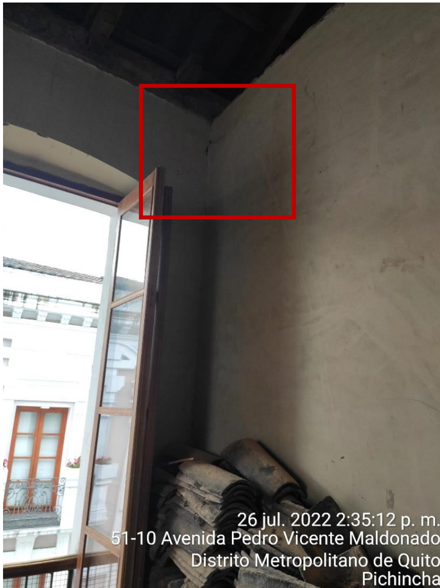
Figura 14. Unión perpendicular entre muros
