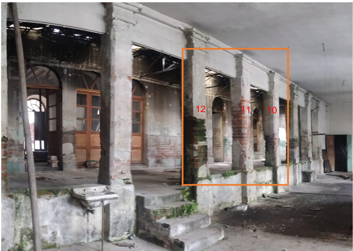
Figura 1. Columnas a eliminar en zona de repositorio
