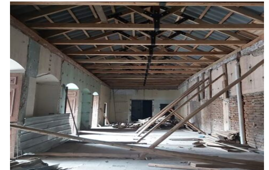
Descripción: Espacio interior bajo una cubierta intervenida en la que se observa estructura de madera y metal.
