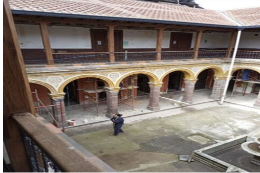
Descripción: Vista interior actual con trabajos para la recuperación de pintura mural original.
