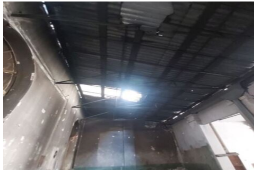
Descripción: Vista de cubierta metálica con planchas de fibrocemento en uno de los bloques posteriores.
