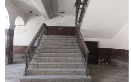
Descripción: Vista de escalera de hormigón armado, en la parte superior se observa una viga del mismo material.
