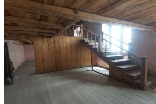
Descripción: Espacio interior en el que se ha añadido un entrepiso, pared y escalera de madera.
