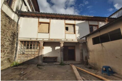
Descripción: En el subsuelo, espacio posterior intervenido por el antiguo FONSAI en el año 2005, con la rehabilitación de la cubierta, en el costado derecho un bloque añadido con materiales modernos.
