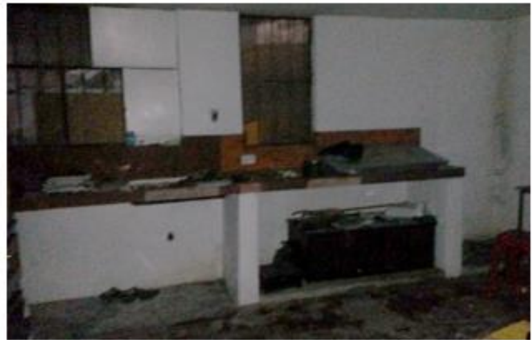
Cuarto 1 de bodega 1 Foto # 3
