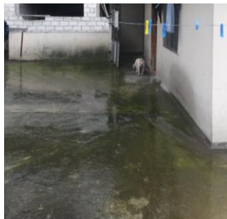
IMAGEN 09: Capa biológica sobre losas (bloque 1) IMAGEN 10: Capa biológica sobre losas (bloque 2)
