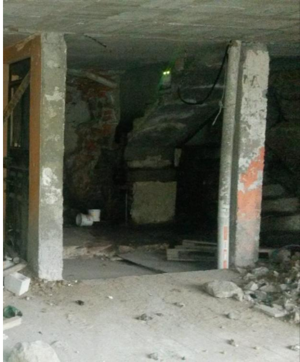
IMAGEN 07: Disgregación hormigón gradas. IMAGEN 08: Disgregación enlucidos (bloque 2)
