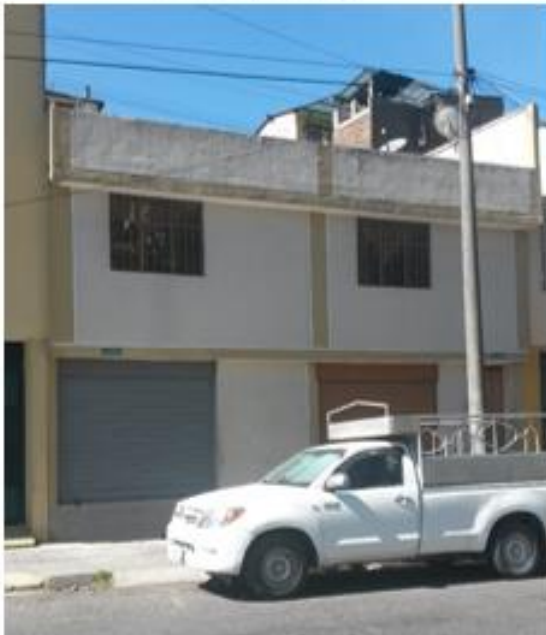
Fachada Frontal Calle Sucre Foto # 1
