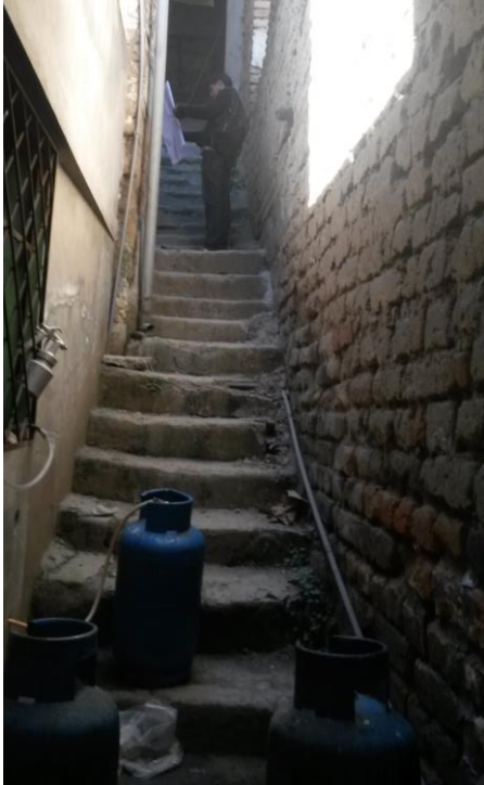
IMAGEN 07: Disgregación hormigón gradas. IMAGEN 08: Disgregación enlucidos (bloque 2)
