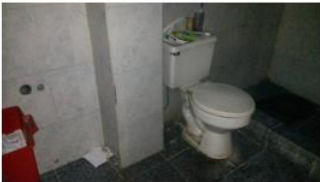
Baño subsuelo Foto # 6
