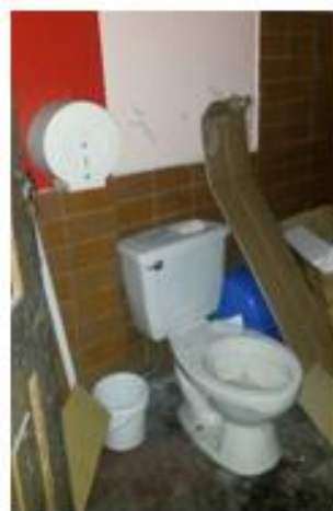
Baño Local comercial 1 Foto # 9
