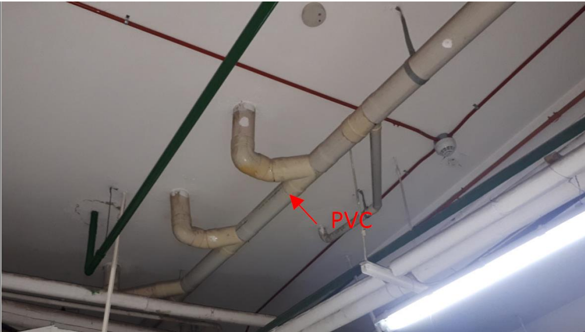
Figura 10. Instalaciones de PVC en techo de Cocina
