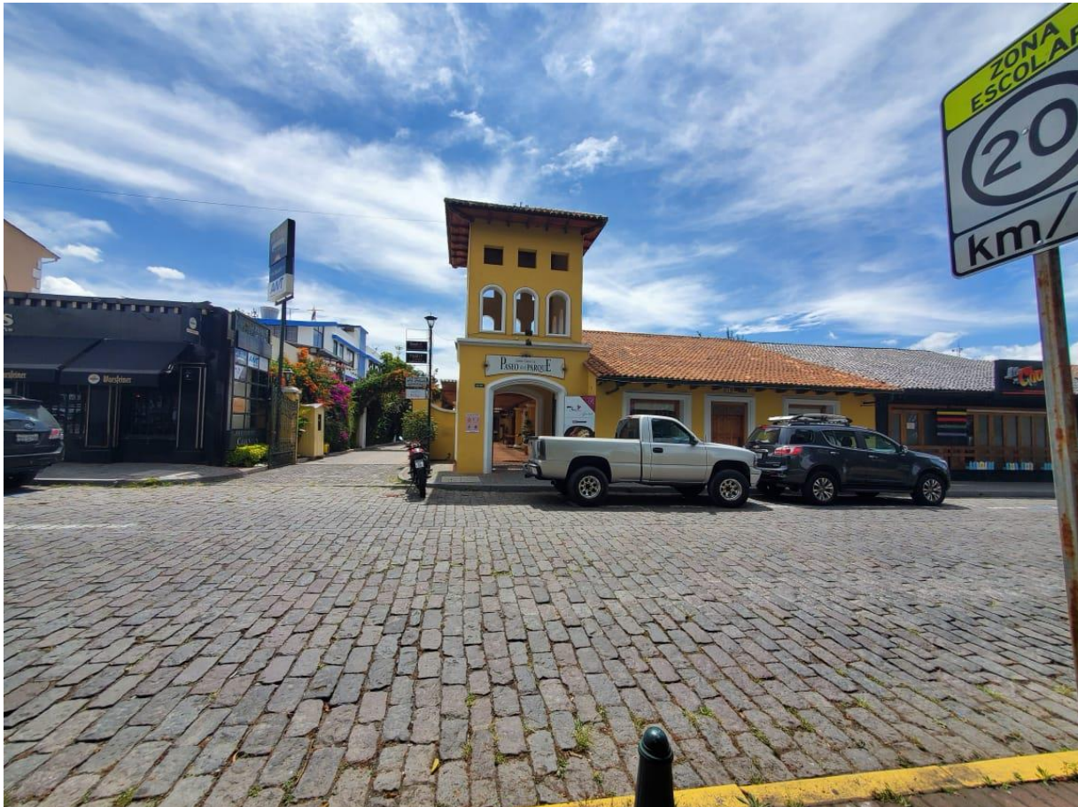
Fachada frontal acorde con el inmueble patrimonial
