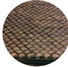
Cubierta de teja
