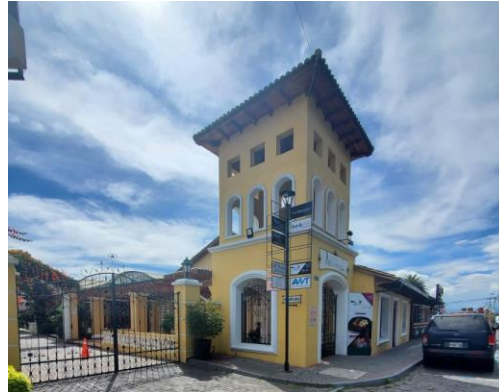
Nota: Imagen de la fachada frontal del Paseo del Parque, desde la calle Francisco de Orellana
