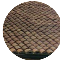
Cubierta de teja
