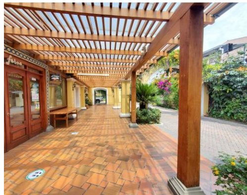
Nota: Vista del local principal al lado izquierdo de la imagen, seguido por la circulación principal lineal del proyecto y la rampa de ingreso vehicular al lado derecho.
