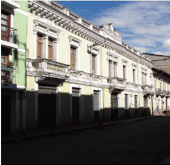
FACHADA HACIA LA CALLE ROCAFUERTE – ESTADO ACTUAL
