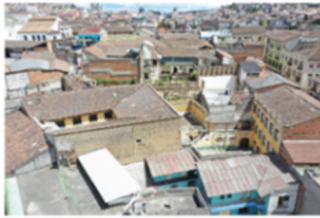
Estado Actual: Inmuebles accesos y deteriorados
