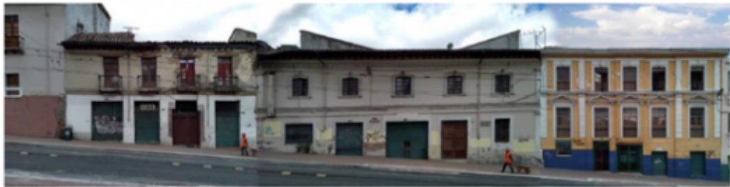
FACHADAS HACIA LA CALLE PEDRO VICENTE MALDONADO-ESTADO ACTUAL
