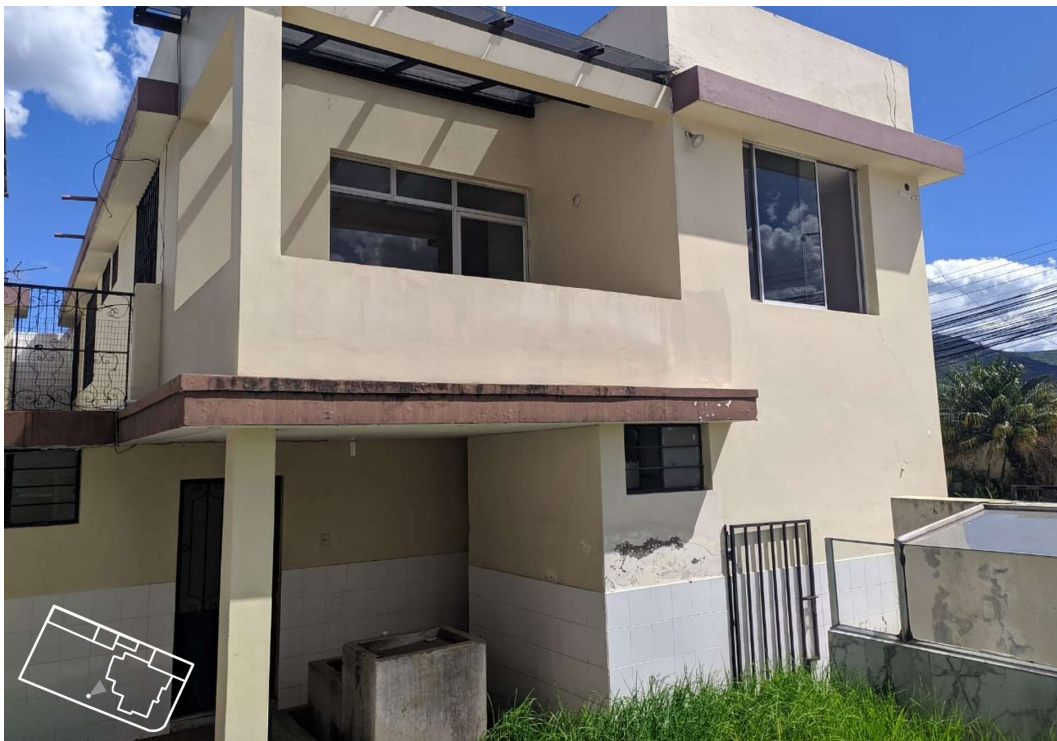
Gráfico 6: Bloque 1 Edificación de 2 plantas lavandería
