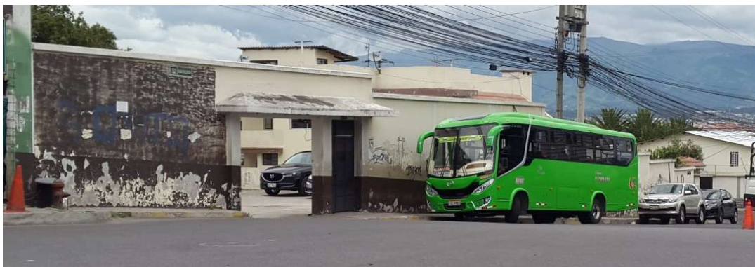
Gráfico 4: Fachada sobre la calle Alba Calderón.
