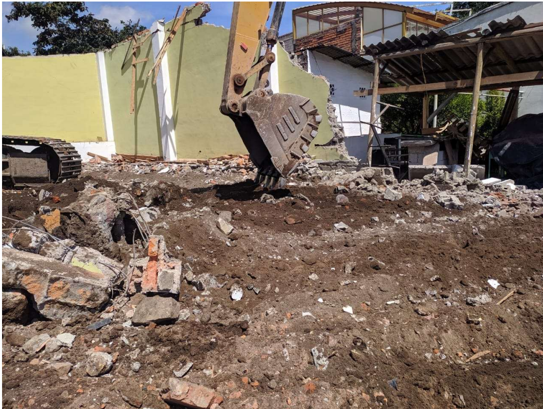
Gráfico 11: Pala Mecánica recogiendo escombros.
