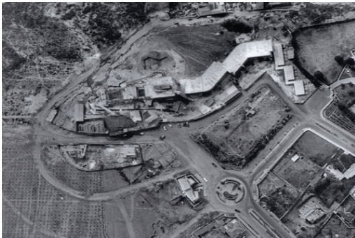
Descripción: Vista del Hotel Quito en su etapa de construcción. Década de 1960 Fuente: Conferencia Arq. Mauricio Luzuriaga
