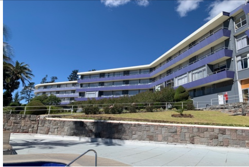
Descripción: Vista de Fachada Posterior del ala Sur Fuente: IMP - DIP
