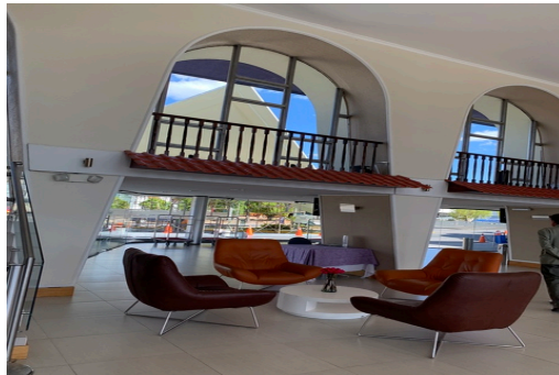
Descripción: Vista general de arco catenario Fuente: IMP - DIP
