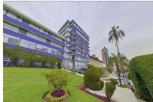
Descripción: Vista general de Fachada Posterior y áreas verdes del Hotel Quito Fuente: Hotel Quito (s.f). https://www.hotelquito.com.ec
