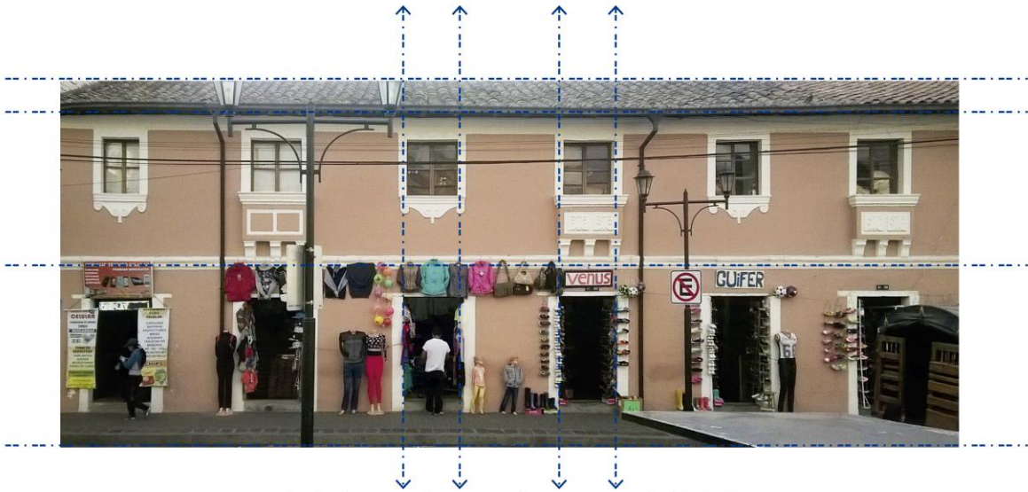
Fachada de casa existente en el parque central El Quinche
