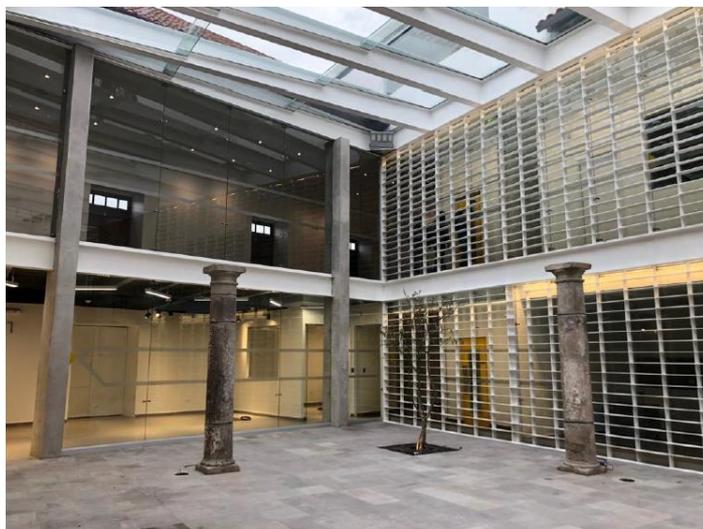
Imagen 10. Cambio formal, cambio de mampara metálica por fachada vidriada.
