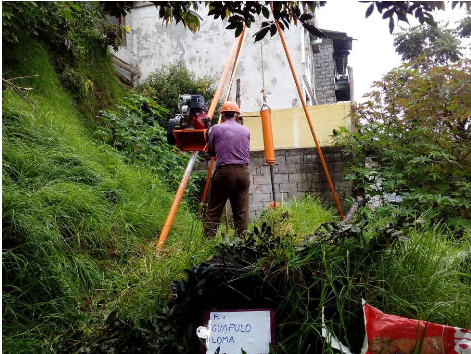
SONDEO P-1, PROCESO DEL ENSAYO DE PENETRACION ESTANDAR SPT
