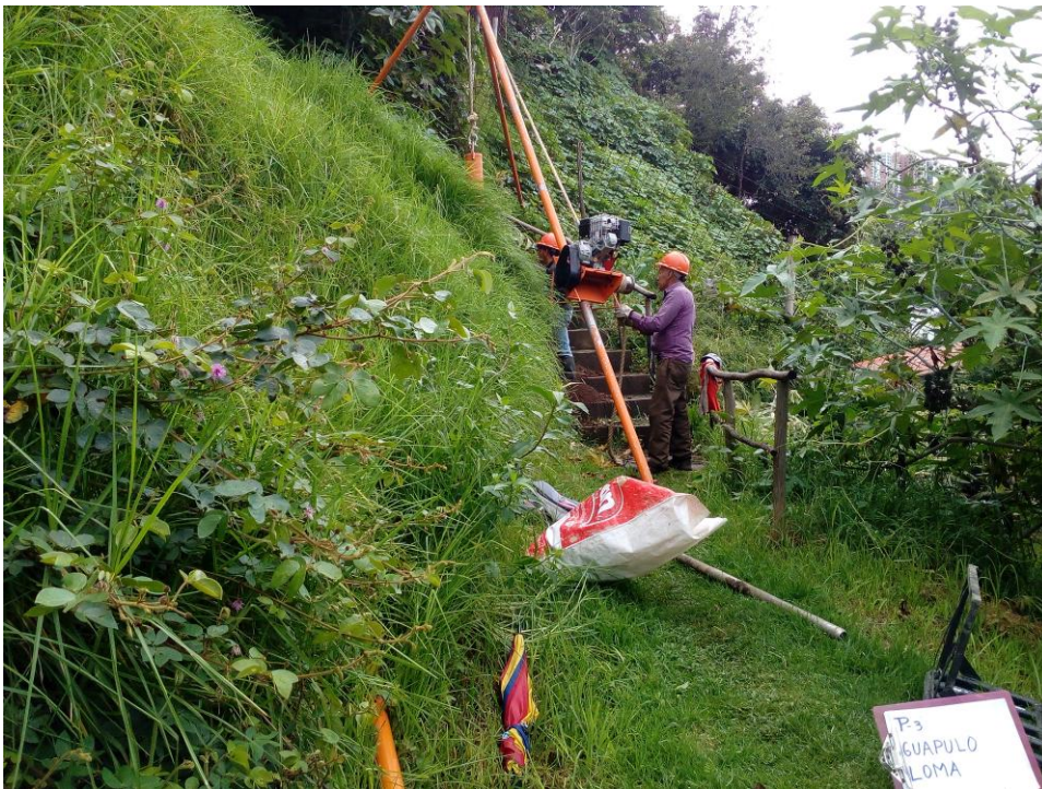
SONDEO P-3, PROCESO DEL ENSAYO DE PENETRACION ESTANDAR SPT.
