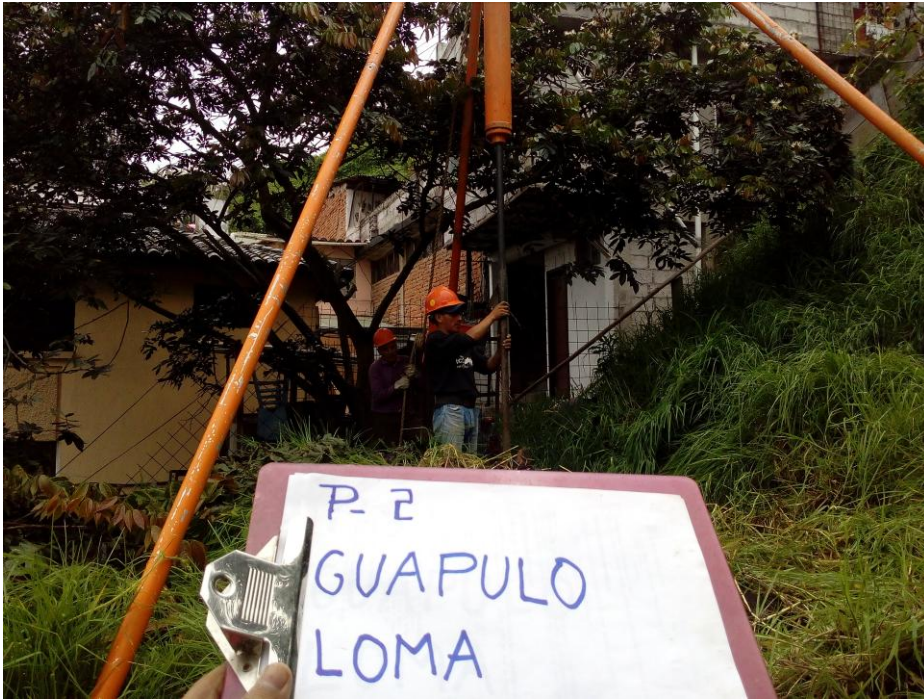
SONDEO P-2, PROCESO DEL ENSAYO DE PENETRACION ESTANDAR SPT.
