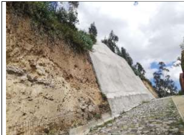
Fotografía 8.1.7. Muro de contención
