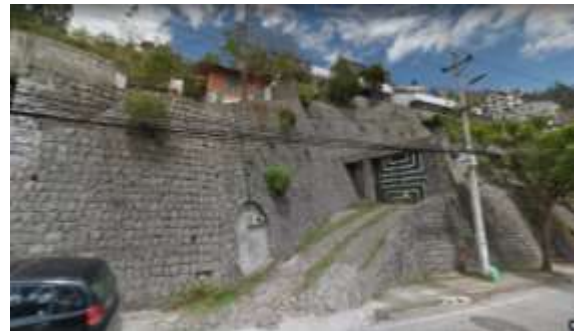
Fotografía 8.1.2 Vista frontal del predio 530987
