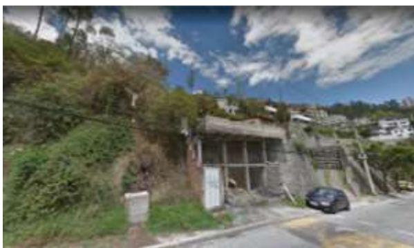
Fotografía 8.1.1 Vista frontal del predio 530987
